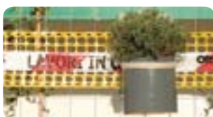
06 RECINZIONI PROVISORIE PER CANTIERI
